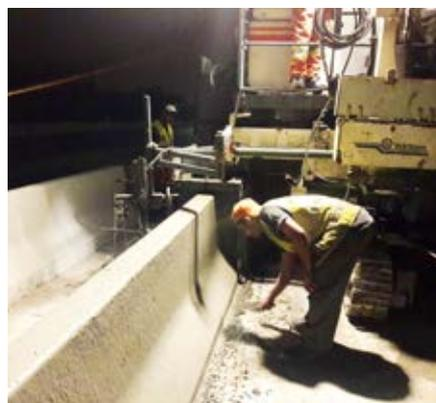
Machine à coffrage glissant pour glissières en béton extrudé, bordures ou caniveaux.
